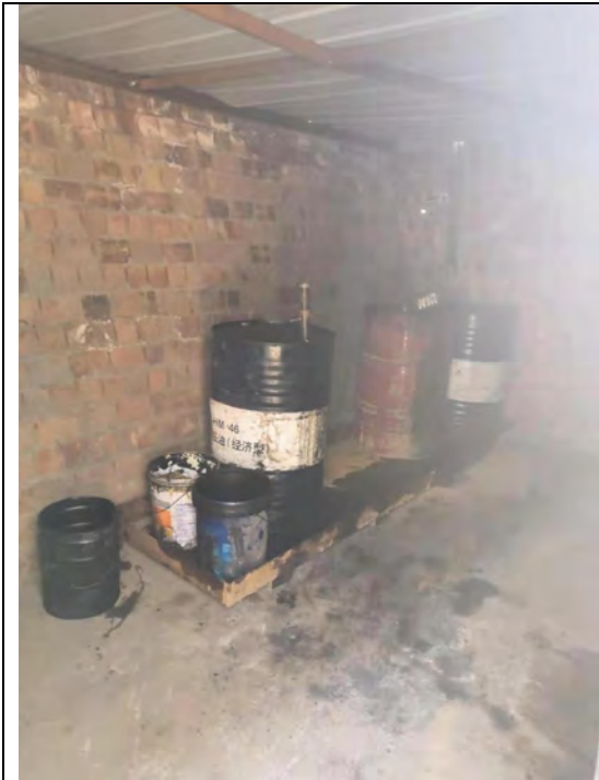
危险废物暂存间
